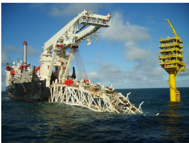
Obr. 4 Pokládka potrubních dílců na dno Baltského moře [7]
