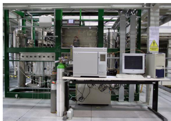
Obr. 8 Systém čištění, dávkování a kontroly čistoty helia s plynovým chromatografem v popředí
