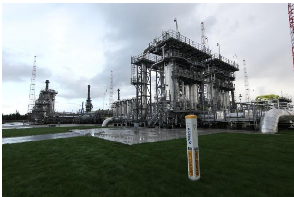
Obr. 2 Kompresní stanice Portovaja o výkonu 366 MW před vstupem plynovodu do moře [7]
