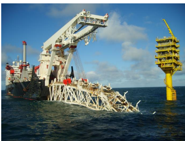
Obr. 4 Pokládka potrubních dílců na dno Baltského moře [7]
