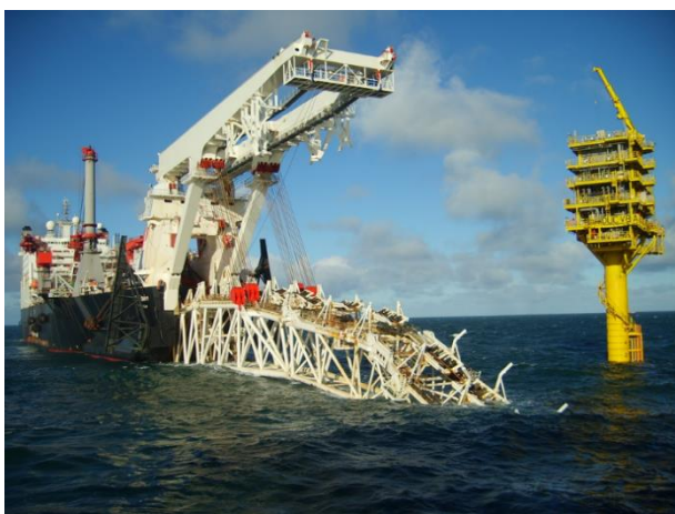
Obr. 4 Pokládka potrubních dílců na dno Baltského moře [7]
