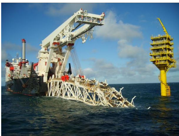
Obr. 4 Pokládka potrubních dílců na dno Baltského moře [7]
